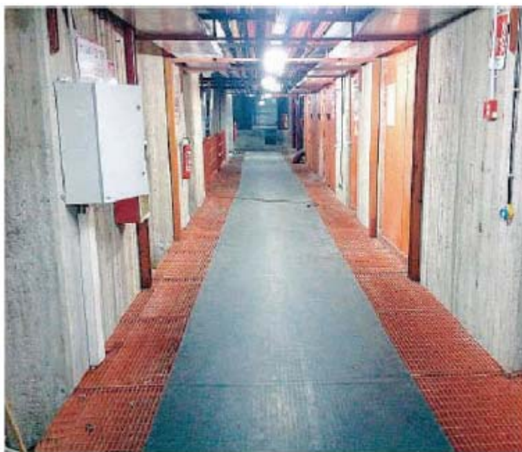
L'interno del Palacongressi. È uno dei cantieri da ultimare al più presto
